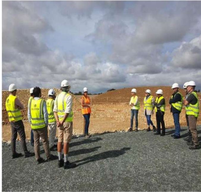
La première phase des travaux - fouilles, voirie, excavation - est achevée (@ Y.P.)
